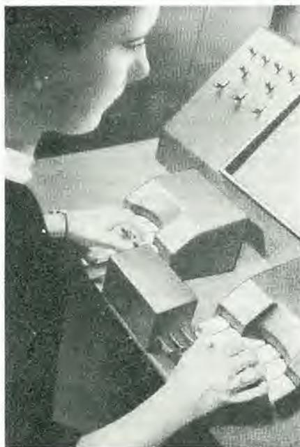
Figura 3. La tastiera del veder (voice operation demonstrator). Si controllano manualmente una serie di filtri del formante, e l'operatore deve essere molto abile per dare origine a suoni coerenti.
