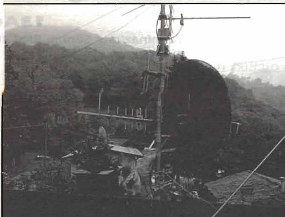
Foto 5 - 7 elementi, dipolo UHF e parabola TV-SAT
