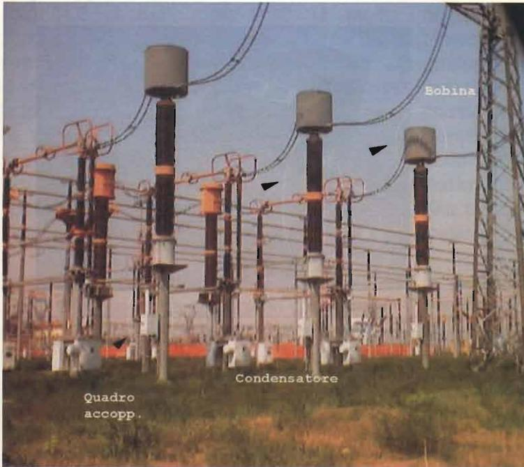
Figura 5 - Vista degli organi d'accoppiamento delle onde convogliate su elettrodotti a 380KV. Si vedono le bobine di sbarramento da 200mH (una per fase). Queste trovano supporto meccanico sul condensatore d'accoppiamento da 2000pF. Nel quadro vi è il trasformatore d'accoppiamento che provvede anche all'isolamento dall'impianto in tensione.
