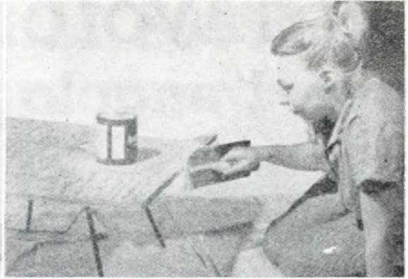
Spalmare il mastice è stata cosa facile grazie ad una cazzuola a denti di sega che assicura uno spessore uniforme dello strato. Il mastice è ad essiccazione lenta.
