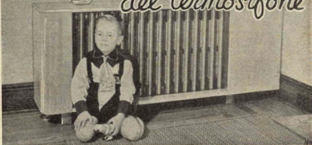
**Una funzionale copertura in legno, che oltre a dissimulare la forma convenzionale del radiatore, aumenta anche l'efficienza di quest'ultimo**
