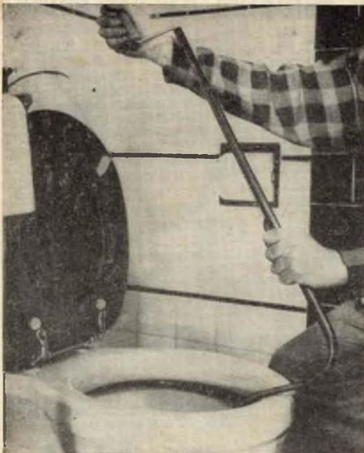
*Dopo avere eseguito una pulitura attraverso il foro di accesso di un sifone, nel richiudere, si abbia cura di rimettere al suo posto la guarnizione ermetica, in buone condizioni di stringere a fondo il caperchietto a vite*
