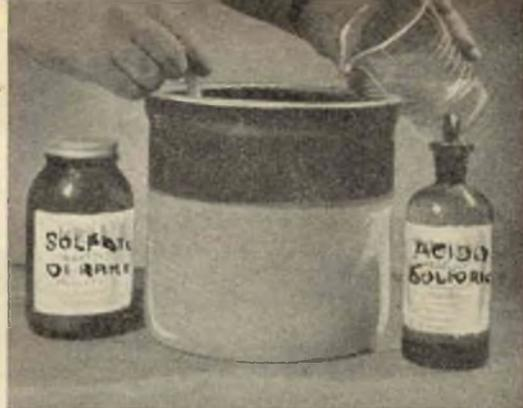
*Preparazione del liquido per il bagno di ramatura. L'acido solforico deve essere aggiunto all'acqua dopo che in questa sia già stato sciolto il solfato di rame, versare l'acido lentamente.*
