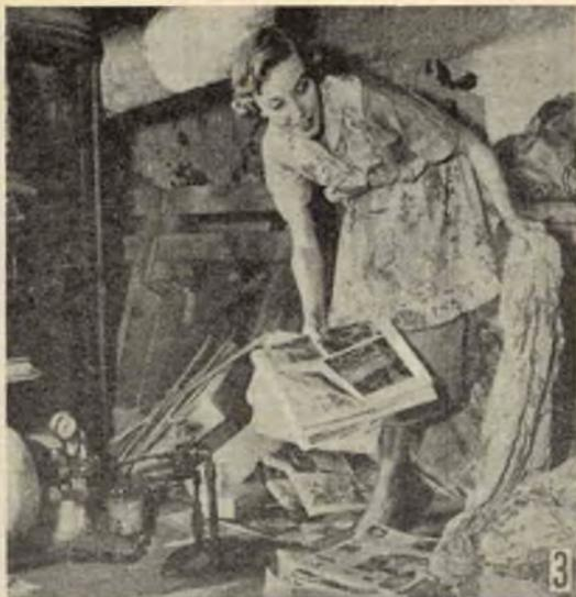
*Non sono poche le cantine ed i solai, in cui capita di trovarsi di fronte ad una simile confusione: essa rappresenta l'ideale per un principio di incendio per autocombustione; ancora più pericolo poi vi è se nella cantina, si trova la caldaia del termosifone, in funzione.*
