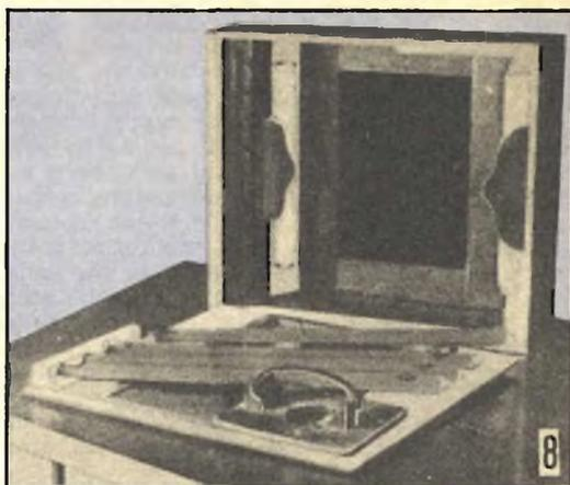
*Veduta interna della valigetta: alla faccia inferiore del coperchio interno si può vedere fissata la coppia delle lampade fluorescenti, ai lati maggiori del foro rettangolare. Notare la disposizione delle zampe di legno e della piattaforma.*
