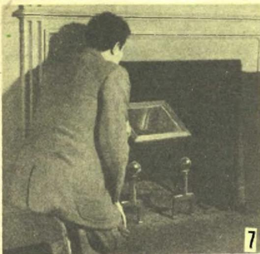
*Un pratico sistema per ispezionare una condotta nella sua quasi totalità, senza rischiare di vedersi cadere addosso qualche fiocco di fuliggine: si tratta semplicemente di impiegare uno specchio inclinato a 45°*
