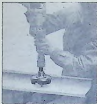
Einschneiden eines Loches mit der Sägeglocke
