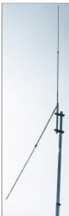
Bild 1: Vertikale Montage der R1
