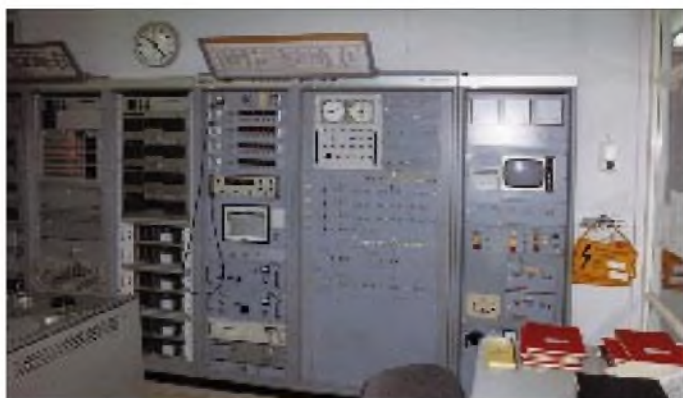
Blick in die Steuerzentrale der Relaisstation Malta. Hier wurden Programme, Sender und Antennen zusammengeschaltet.
