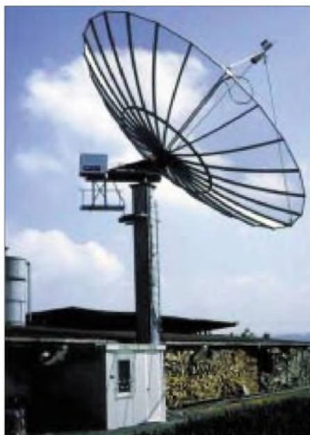
Die 6 t schwere Konstruktion des 10-m-Spiegels
