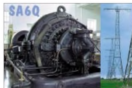
Der 200 kW Alexanderson-Alternator und die 127 m hohen Antennen
