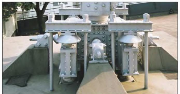
Die Füße des *Langen Lulatsch* schob man erst nach dem Zusammenbau des Turms unter die Tragbeine.
