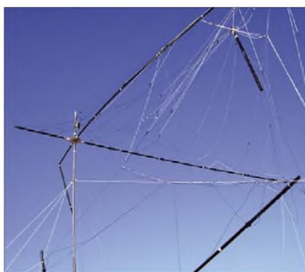
Der beim Sturm beschädigte Spider-Beam
