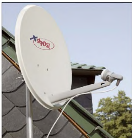
Bild 1: Fertig montierte Satellitenanlage für skyDSL
