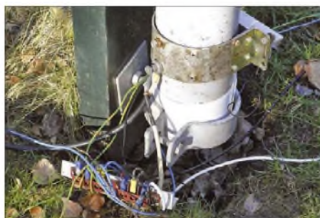
Bild 6: Isolation des Kurbelmastes gegen Masse
