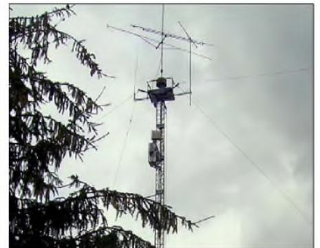
**Der Antennenmast von DB0ZWI: Höhe 20 m und mit einer Arbeitsbühne befahrbar. Am Mast, in 5 m Höhe, ist die komplette Stromversorgung des Digipeaters, die durch ein Schaltnetzteil 230 V/12 V (80 A) realisiert ist, angebracht. In 18 m Höhe befindet sich der Schrank für die Linktransceiver sowie den Transceiver für die WLAN-Verbindung zur Hochschule in Zwickau.**
