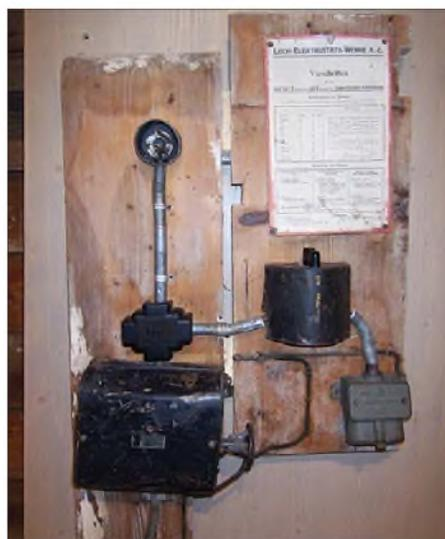
So sah die Stromspeisung eines Bauernhofs in den 40er-Jahren aus. Ein angeschlagenes Merkblatt gab darüber Auskunft, an welchen Zeiten keine elektrische Energie aus dem Netz entnommen werden durfte. Sonst drohte dem Netzbetreiber eine Überlastung! Fotos: DL1MEH
