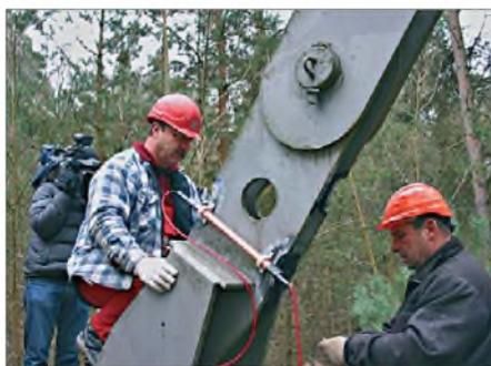
**Bild 6: Montage einer Sprengladung an einem der Pardonfundamente des Mastes**
