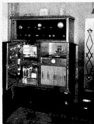
Der geöffnete Radioschrank zeigt, welche saubere Arbeit da geleistet wurde. Oben der Empfänger, links Netzanschluß mit Ladevorrichtung, in der Tür die Instrumente, unten der dynamische Lautsprecher. Rechts Schallplattenlaufwerk und darunter Plattenstapel.
