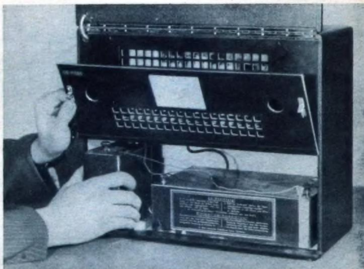
Oben der eigentliche Empfänger mit Lautsprecher, unten die Batterien. Das gewährleistet nicht nur ein angenehmes Tragen, sondern auch ein bequemes Auswechseln der Batterien.
