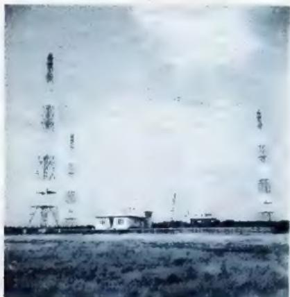
Drei Antennen-Masten tragen die Empfangs- und Sende-Antennen, Sender und Empfänger sind im Gebäude (zwischen den Sendermasten) untergebracht.
