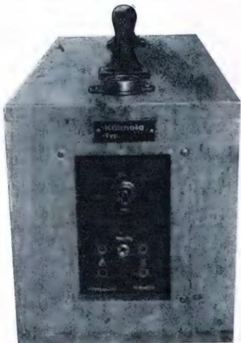
Der Universal-Mikrofon-Batteriekasten-Verstärker, links in der Außenansicht, rechts geöffnet. Man erkennt das Batteriefach, das für jede Art von Batterien reichlich Platz bietet, und das eigentliche Verstärkerfach.
