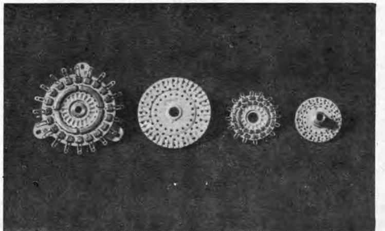
Bild 3. Die auseinandergenommenen Schalterplatten lassen den durchdrachten Aufbau von Kontaktteilen erkennen. Ein besonderer Vorzug der neuen Schalter besteht darin, daß bewegliche Anschlüsse vermieden werden. Die beiden ersten Platten (von links nach rechts) gehören zum Meß- und Leistungsschalter E 2, während die beiden kleineren Platten Teile des Stufen- und Wellenschalters E 3 darstellen. (Bilder: Knollmüller)
