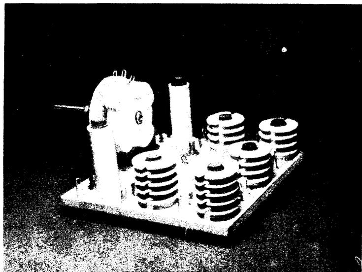
Bild 7. Superspulenplatte für Einlochmontage
