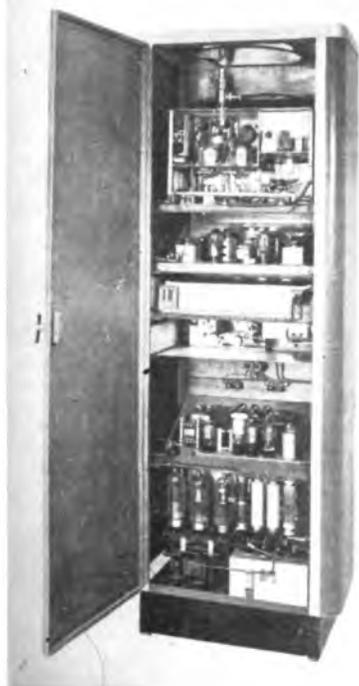
Bild 1 Innenansicht des ersten UKW-Versuchssenders des Bayerischen Rundfunks, der von der Fa. Rohde & Schwarz gefertigt wurde (oben: Endstufe, darunter Oszillator- und Verdopplerstufen, unten Netzteil)
