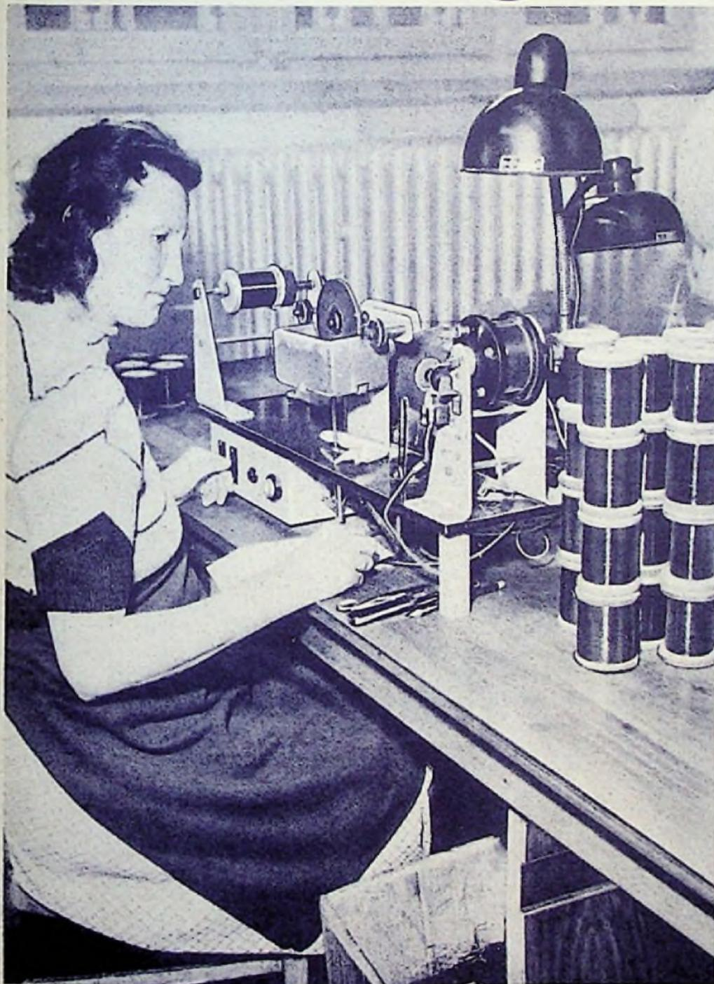
Im Telefunken-Rundfunkgerätekwerk Hannover werden automatische Drahtprüfmaschinen verwendet, die eine Prüfung der lackisolierten Drähte auf Fehler ermöglichen. Die abgebildete Maschine wickelt die selbsttätig einstellbare Länge Draht auf und führt ihn dabei durch ein elektrisch leitendes Bad. Bei Fehlern in der Isolation wird über den zu prüfenden Draht und das Bad ein Stromkreis geschlossen, der mit einem Zählrelais die Zahl der Fehler registriert. (Foto: Carl Stumpf)
