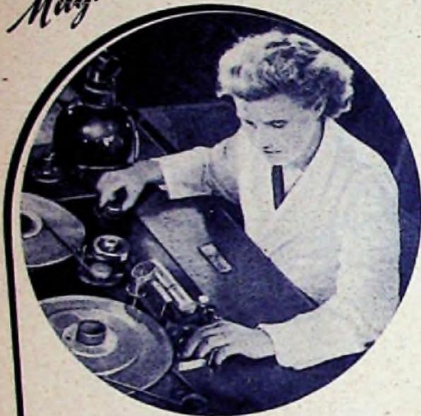
Auf die Sorgfalt, mit der das Magnetophonband BASF geprüft wird, kommt es an. — Sicherer Blick, Fingerspitzengefühl und eine automatisch arbeitende Folozelleneinrichtung, die auf kleinste Fehler genauestens reagiert, sind zuverlässige Bürgen für die hohe Fehlerfreiheit und große Gleichmäßigkeit der Typen L extra und LGH.
