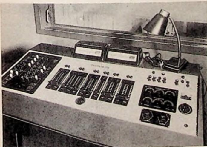
Bild 3. Reglettsch mit Reglern, Druckknopfsteuerung für die einzelnen Betriebsarten und Lichtzylinder-Aussteuerungsmessern
