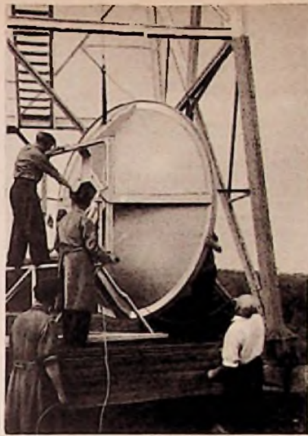
Telefunken ist fertig - Die Richtantennen der von Telefunken gebauten Teilschnitte der Dezistrecke Hamburg-Köln, über die der NWDR am 1. Weihnachtstag das Hamburger Fernsehprogramm ins Ruhrgebiet und Rheinland übertragen wollte, wurden rechtzeitig montiert, aber die Verstärker konnten nicht aufgestellt werden, weil die von der Bundespost verpflichteten Baufröhen trotz Koksböjen - wie Dr. Gladenbeck mitteilte - die Räume nicht trocken bekarnen. Erst Anfang Januar soll die Strecke betriebsbereit sein. Unsere Bilder zeigen Teilschnitte des Telefunken-Bauabschnittes.
