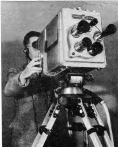
Die neuen Image-Orthikon-Kameras der Fernseh GmbH arbeiten mit parallaxenfreiem Sucher, und sie sind gegenüber bisherigen Konstruktionen leichter und wendiger in der Handhabung
