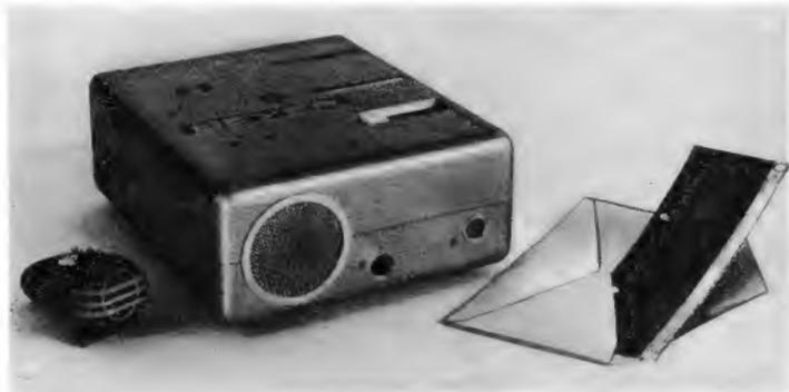
Beyer-Diktiergerät; rechts eine der dafür verwendeten Magnettonfolien
