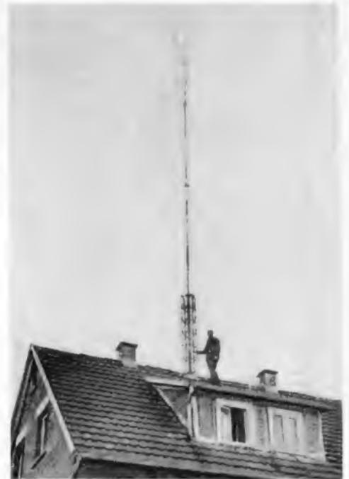
Antennenmast für eine drehbare Fernsehantenne
