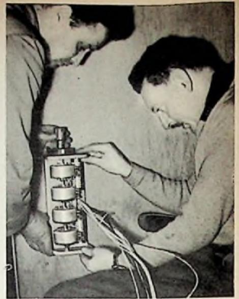
Bild 4. Montage eines Philips-Vierkanal-Saalreglers in einem Lichtspielhaus
