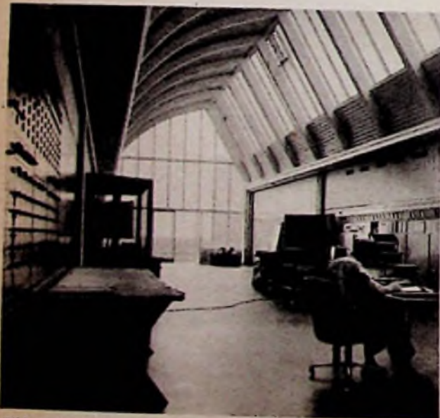
Bild 3. Senderraum; rechts an der Wand die beiden Telefunken-Sender, links das Antennen-Schallfeld (BBC)
