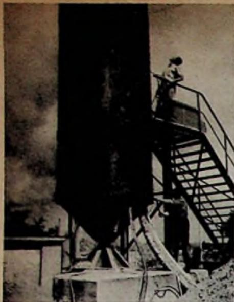
Mehr als 70 Tonnen drücken auf den Betanklotz unter dem Rohrmast. Rechts Einstieg zum Fahrstuhl. Aufn.: Hans Müller
