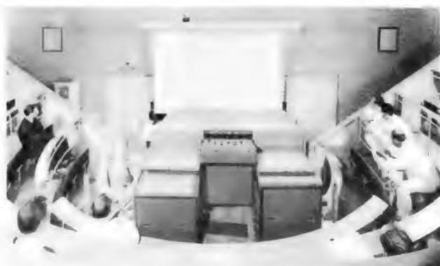
Bild 3. Großprojektor mit drei Schmidt-Hohlspiegelsystemen im Hörsaal der Chirurgischen Universitätsklinik Frankfurt/M. Bildgröße: max.  $3 \times 4$  m, Spitzenhelligkeit: 50 apostilb an einer Perlwand mit Lichtgewinn  $\approx 2,5$ ; Kontrast:  $1 : 30$ , Bildnorm: CCIR mit 50 Halbbildern/sec., Auflösung: 500 Zeilen
