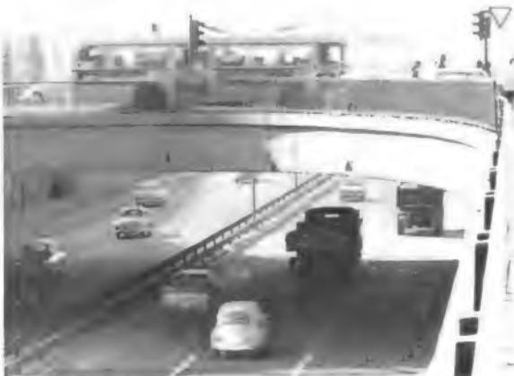
An der Brücke über die sechsspurige Stadtautobahn in Berlin sind drei Ultraschall-Detektoren zu erkennen. Sie ermitteln die Verkehrswerte, die an den Meldespeicher des Signalrechners weitergeleitet werden
