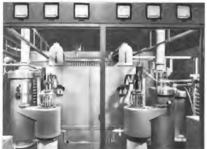
Bild 3. Blick auf die Endstufe mit den siedegekühlten Röhren vom Typ RS 1041 V
