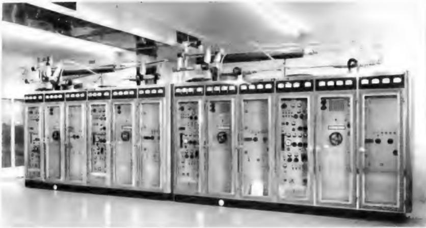
Zwei UKW-Hörfunksender mit je  $2 \times 5$  kW und aktiver Reserve, d. h. bei Ausfall einer 5-kW-Endstufe arbeitet der Sender mit der halben Leistung weiter, die Anpassung schaltet sich automatisch richtig um
