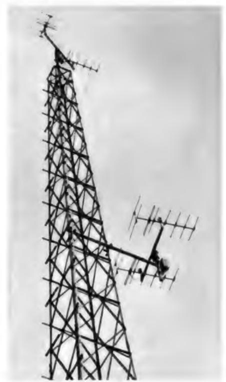
Bild 2. Gitterturm mit Yagi-Antennen
