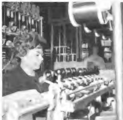
Bild 4. Moderner Wickelautomat für die Spulenfertigung
