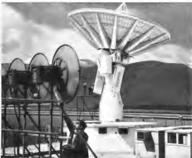
Bild 1. Die 13,4 m große Parabolantenne ist auf einem achteckigen Gebäude montiert; daneben stehen zwei Kontrollwagen mit den Hilfssystemen für Sendung und Empfang
