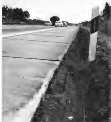
Bild 5. Verlegung der Induktionsschleife neben der Autobahn bei Berkhof, etwa 30 cm tief
