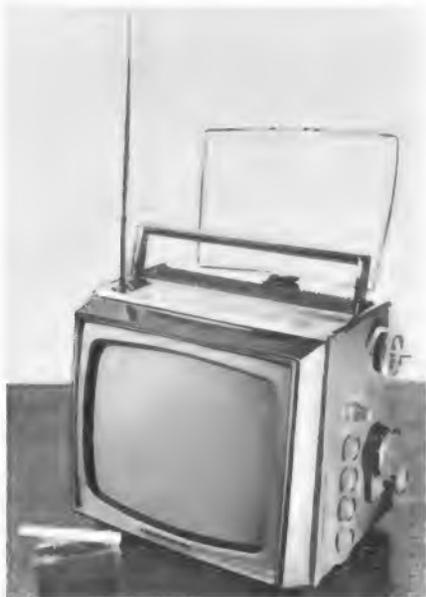
Fernsehempfänger National TR-912 mit 23-cm-Bildröhre für Batterie- und Netzbetrieb
