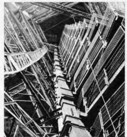
Bild 2. Verlauf des Hohlleiters R 6 im Süd-Feiler des Eiffelturmes
