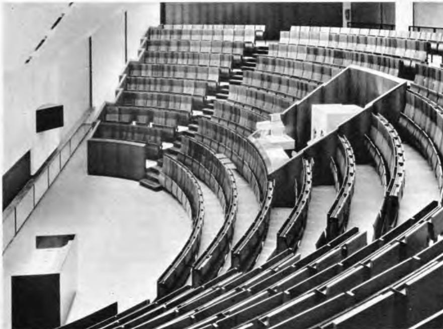
Bild 2. Blick in einen Hörsaal des Universitätsklinikums Berlin-Steglitz. In den Stuhlreihen ist eine Kanzel für den Farbfernsehgroßbild-Simultanprojektor und das Fernseh-Lesegerät ausgespart. Vorn links das Regiepult mit Monitoren für den Dozenten
