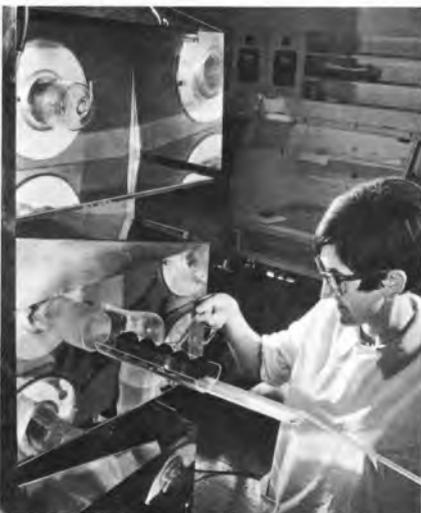
Bild 13. Das Beladen eines Diffusionsofens mit Siliziumscheiben
