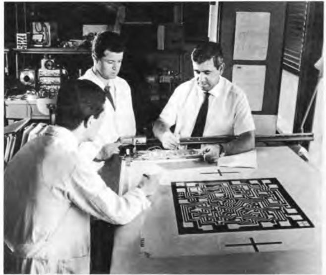
Bild 20. Die Herstellung des vergrößerten Zeichnungsoriginals der integrierten Schaltung als Vorlage für die Fotomaske
