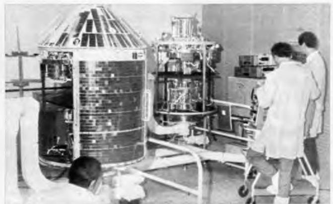
Links der Prototyp, dahinter die erste der beiden Flugeinheiten des deutschen Forschungssatelliten *Azur* (Foto: Messerschmitt-Bölkow GmbH)
