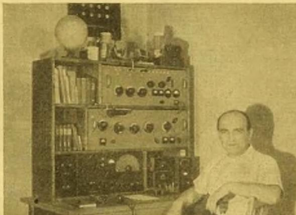
Unsere Fotos zeigen einmal den Operator an seiner Station, die er mit viel Fleiß und Mühe selbst gebaut hat. Auf dem Gestell befinden sich einige Antennenfilter, darunter die Pa-Stufe, darunter der Oszillator und die Verdopplerstufe. Ganz unten stehen der Empfänger und rechts außen das Grid-Dip-Meter. Das andere Foto zeigt den Pa-Einschub mit seinem mustergültigen Aufbau und der Verdrahtung.
