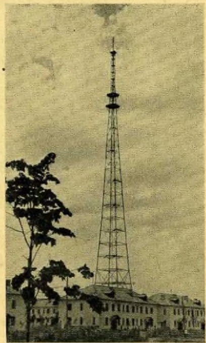
In Kason (UdSSR) wurden die Montagearbeiten am Bau eines neuen Fernsehentrums beendet. Unser Bild zeigt den Antennenmast mit der Fernsehantenne.
