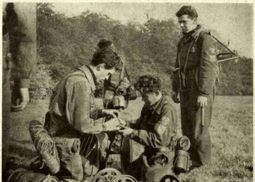
Das schnelle und richtige Herstellen von Kabelverbindungen ist in erster Linie Übungssache
