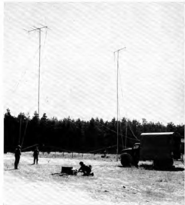
Am Einsatzort angekommen, werden die Zubehörteile wie Antennen-träger, Richtseile, Abspannseile und Antennen entladen. Der Aufbau der Richtfunkstation beginnt. Seine Norm beträgt 45 Minuten (oben links)
