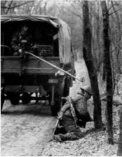
Wo es das Gelände zuläßt, wird die mechanische Verlegeeinrichtung für leichtes Feldkabel eingesetzt. In einer Stunde kann der Trupp damit bis zu 8 Kilometer Kabel verlegen (oben links)
