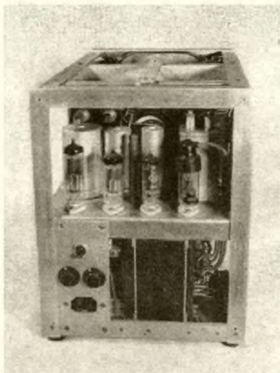
Bild 16: Blick von oben auf die Chassis des Oszillographen
