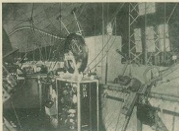
Telefunken-Flugzeug-Funkstation 262 F, 1 – Stromquelle, 2 – Propeller, 3 – Dräselkette, 4 – Sender, 5 – Empfänger, 6 – Haspel für Antenne, 7 – Isolierrohr, 8 – Taste, 9 – Brustmikrofon, 10 – Kopfhörer
