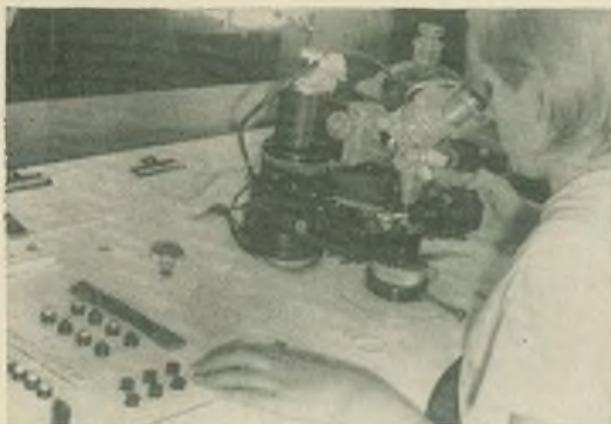
Bild 2: Die auf der Halbleiterscheibe befindlichen Mesa-Elemente werden vor dem Trennen über feine Meßfühler ausgemessen, unbrauchbare gekennzeichnet
