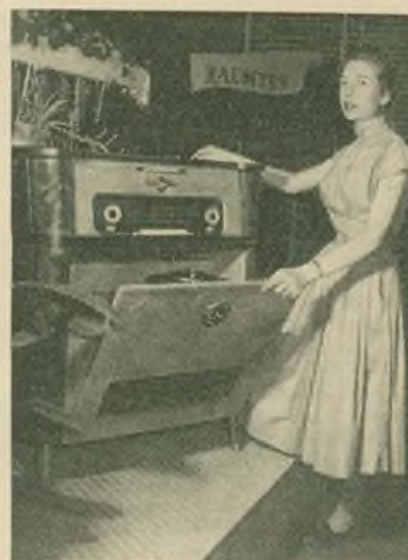
Die Musiktruhe „Sinfonie II“ des VEB Stern-Radio Staßfurt besaß einen Superhet mit UKW-Bereich und 5 Klangtasten sowie einen 10-Platten-Wechsler (1956)
